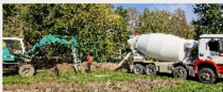
Výkop, výstuž a zalievanie pilót
