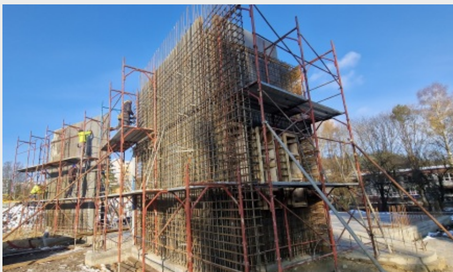
Viazanie stavebnej ocele pre steny kostola
