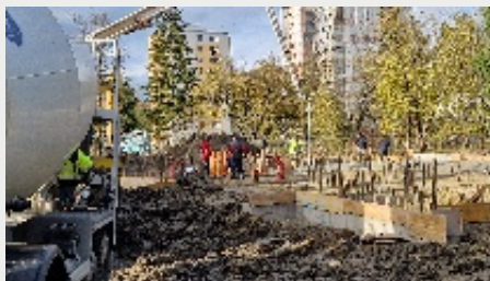
Inštalatárske práce a hutnenie pred betónovaním platne
