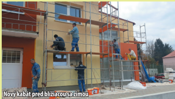
Pripevňovanie sendvičového obkladu
