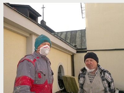
Majstri Straniankovci pri zatepľovaní stropu kostola
